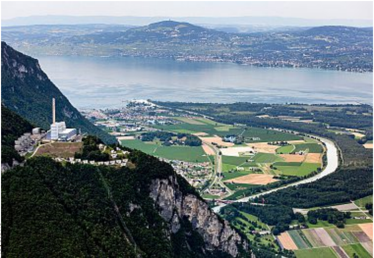
L’ancienne centrale thermique de Chavalon, désaffectée depuis 1999.
