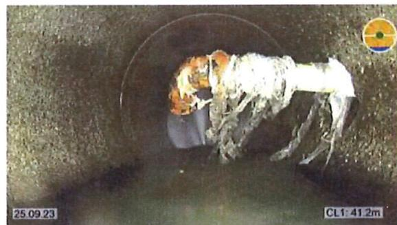
L'une de celles-ci, deux fois moins onéreuse que le remplacement de la canalisation, a pour but de chemiser la conduite. Cette opération consiste à glisser une sorte de gaine flexible enduite de résine à l'intérieur de la conduite existante. Cette gaine est ensuite gonflée pour qu'elle prenne la forme de la conduite et lui redonne son étanchéité.
