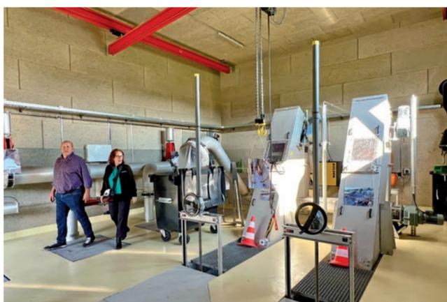
L'intérieur de la station, avec notamment ses pompes et ses dégrilleurs.
