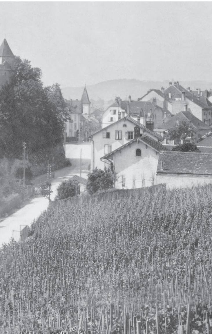
La tourelle de Gex en 1920, qui marquait autrefois l'angle sud-ouest de la muraille du bourg. A droite, on distingue l'enseigne de la quincaillerie Glardon-Grobet. DR
