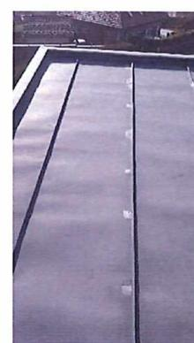
*Toitures BNB et BNC, avec les multiples rhabillages dû à une électrolyse entre les clous et le plaquage*
