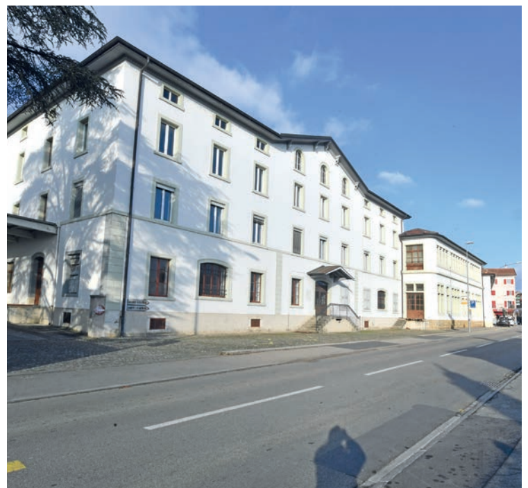
L'ancienne fabrique de tabac Vautier devrait accueillir des logements.
