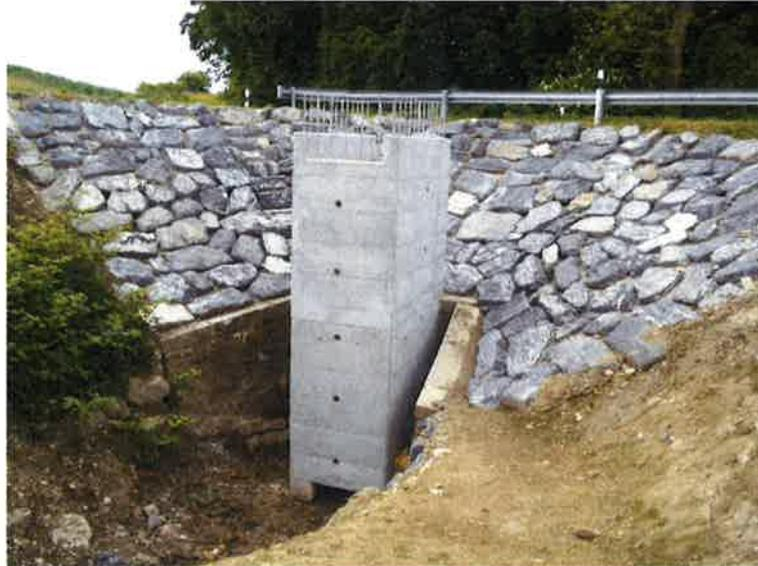
Figure 9 : Exemple de "cheminée" sur le bassin amortisseur de crues du Flumeau à Lavigny (source : Stucky)
