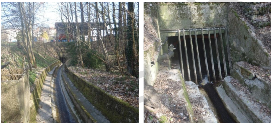
Figure 5 : Canal en aval de la herse (à gauche) et entrée du voûtage (à droite)
