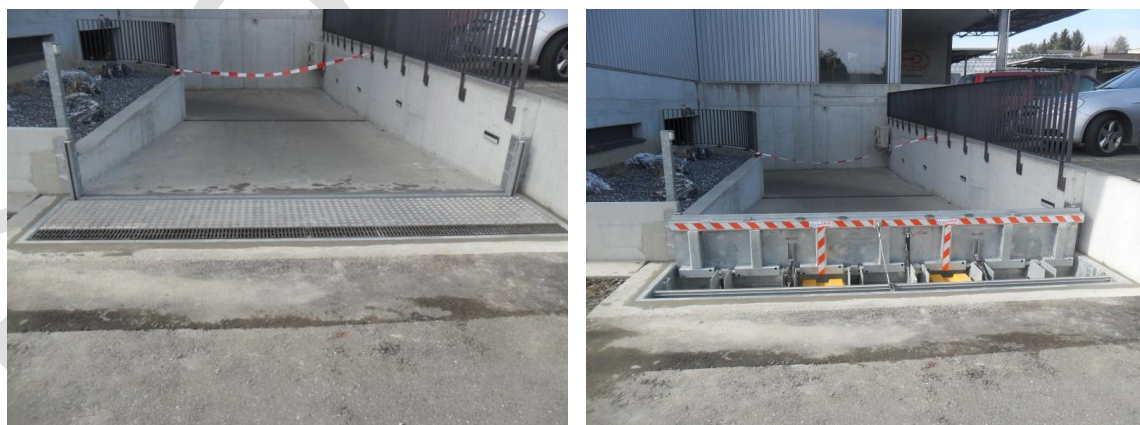
Figure 14 : Exemple de système de protection mobile d'une rampe d'accès ; le système présenté ne nécessite pas d'alimentation électrique et est automatique (source : watersave.ch)
