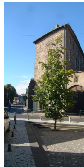
Carrefours sécurisés, St-Flour
