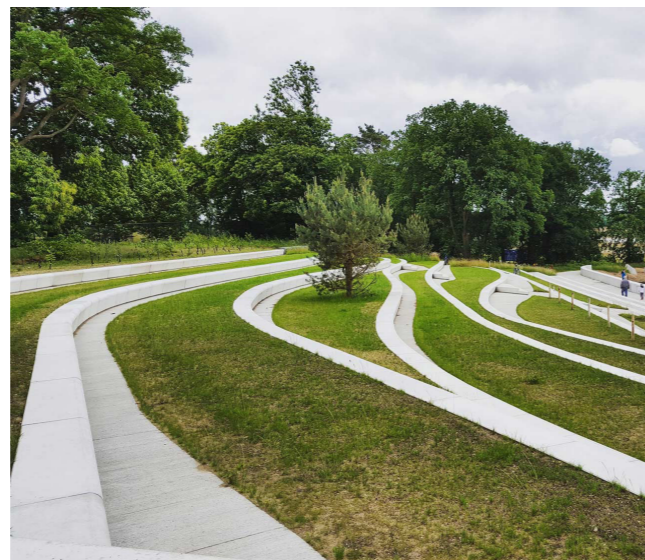
Traitement de la pente sous forme de paliers qui créent autant de gradins, Soesterberg
