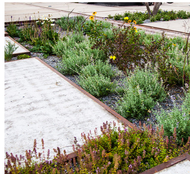
Se servir des matériaux industriels existants pour les aménagements extérieurs, Zollhallen Plaza
