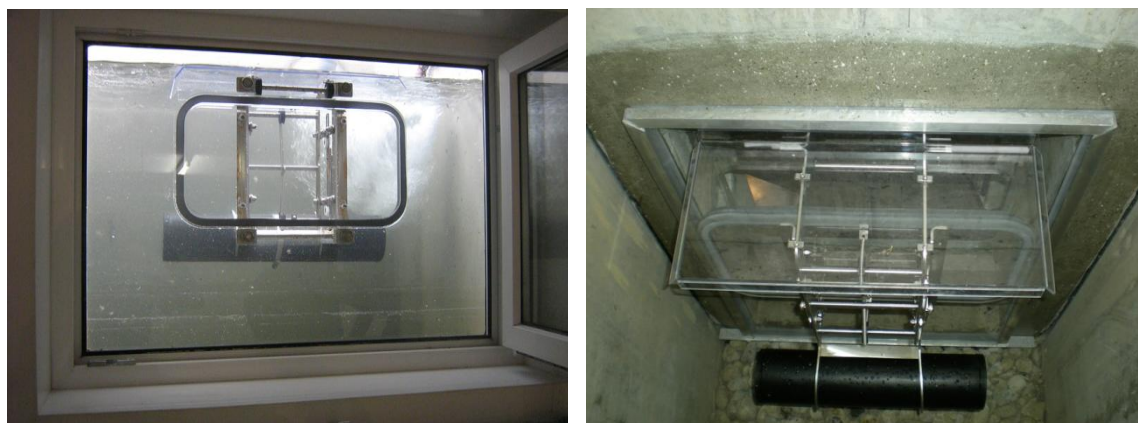
Figure 15 : Exemple de fenêtre se fermant automatiquement au fond d'un saut-de-loup (source : watersave.ch)
