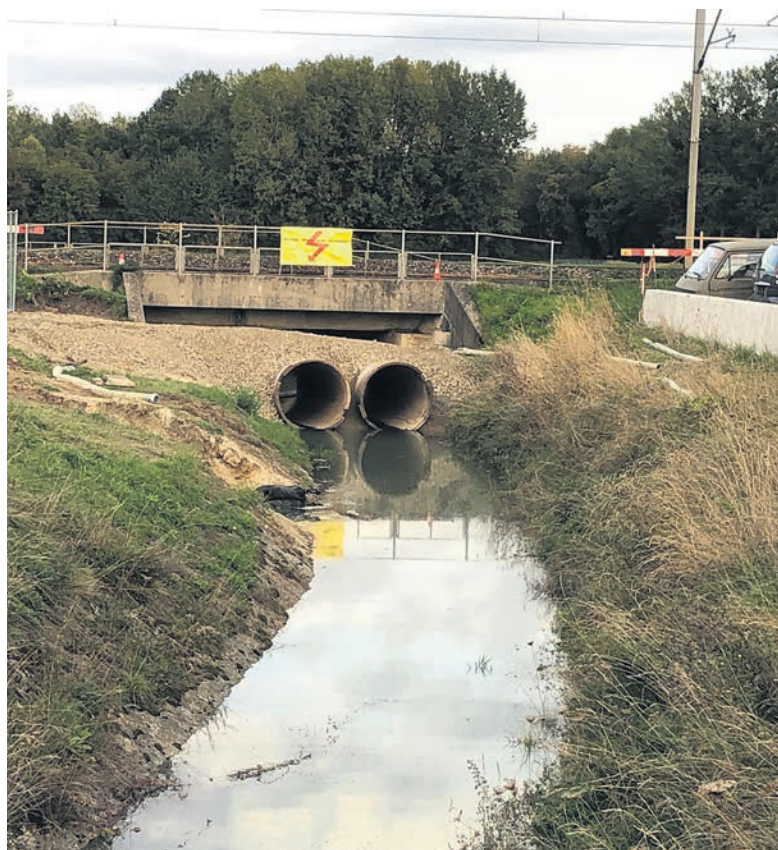
Le passage sous les voies CFF constitue la principale difficulté du chantier.
